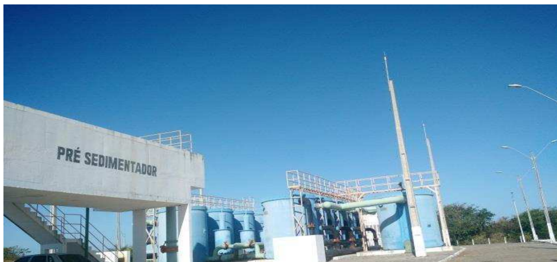
Foto 2 – Pré sedimentador na Estação de Tratamento de Água de Aracati - Ceará
