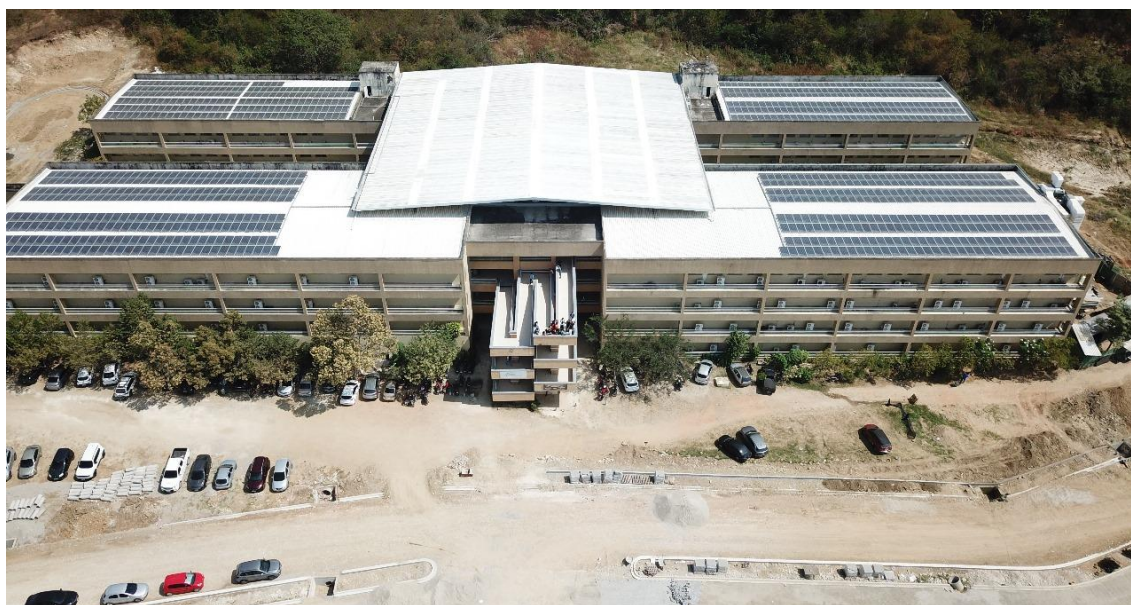
Figura 12. Usina solar de cobertura do Campus das Auroras (UNILAB).
